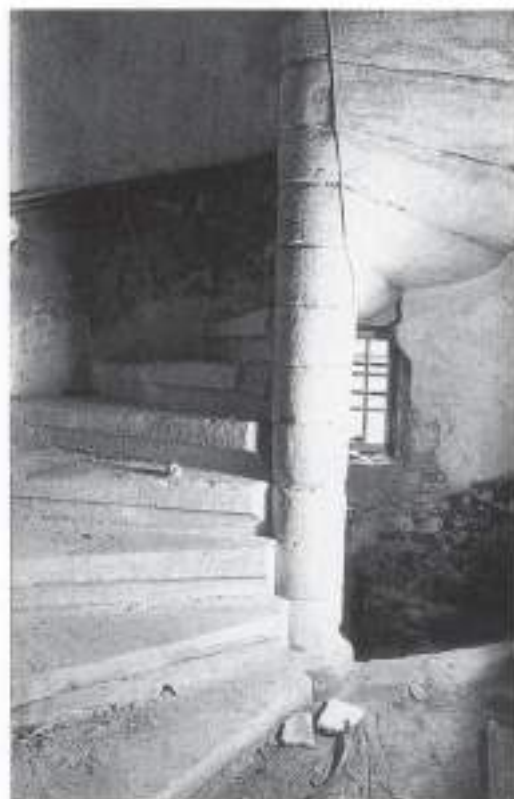
8 Wendeltreppe im Erdgeschoss (1985)
