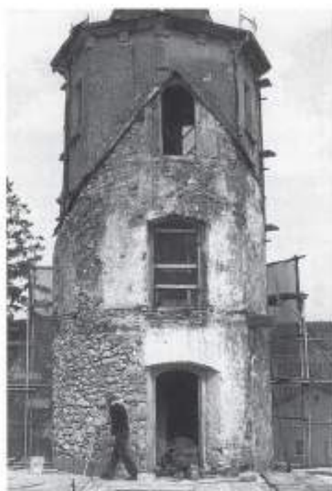
50 Der nach innen freigelegte Turm
