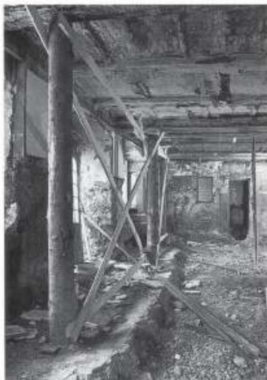
49 Abgestützte Südwestecke im Erdgeschoss
