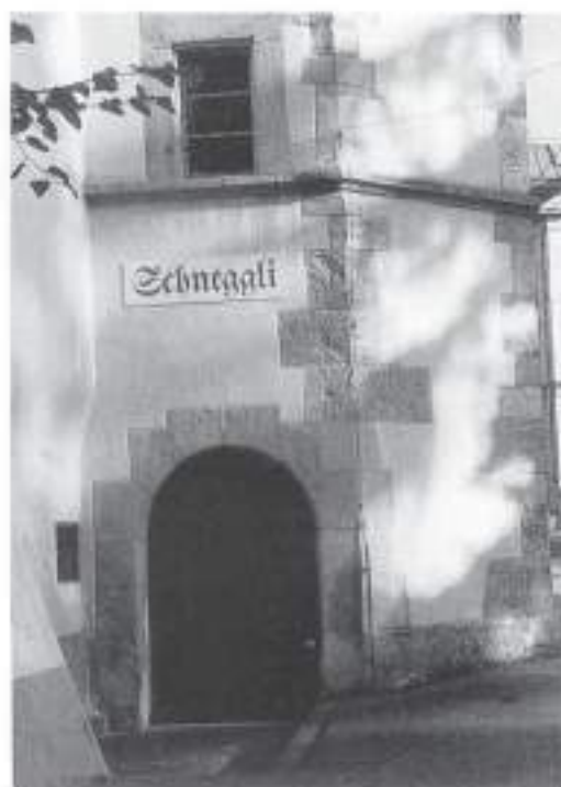
26 Eingang in den Schneggli-Turm (1988)
