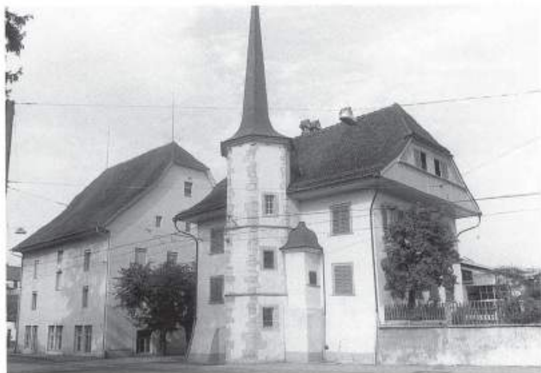
28 Ehemalige Mühle und Kleiner Schneggen von Westen (1988)
